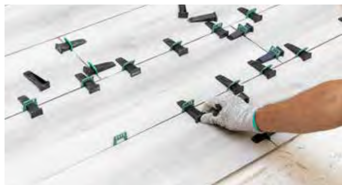
3. Introducir cuñas / Introduce the wedges / Introduire les cales
