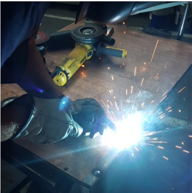
Zona de soldadura. Zone de soudure. Weld zone.
