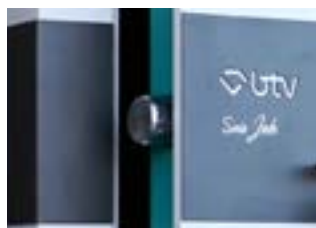
Bulones de Ø25 mm a un lado de la puerta
