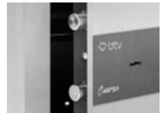
Bulones a los tres lados de la puerta
