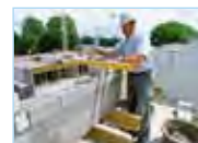
Golpear sin dañar el nivel
